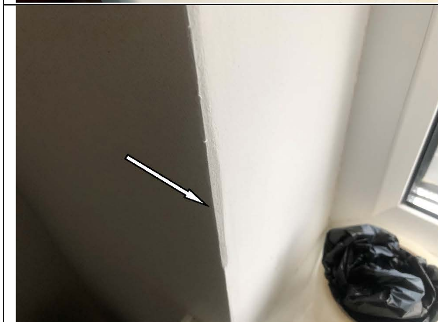
Фото №24. Неровности, царапины на окрашенных откосах в кухне.
