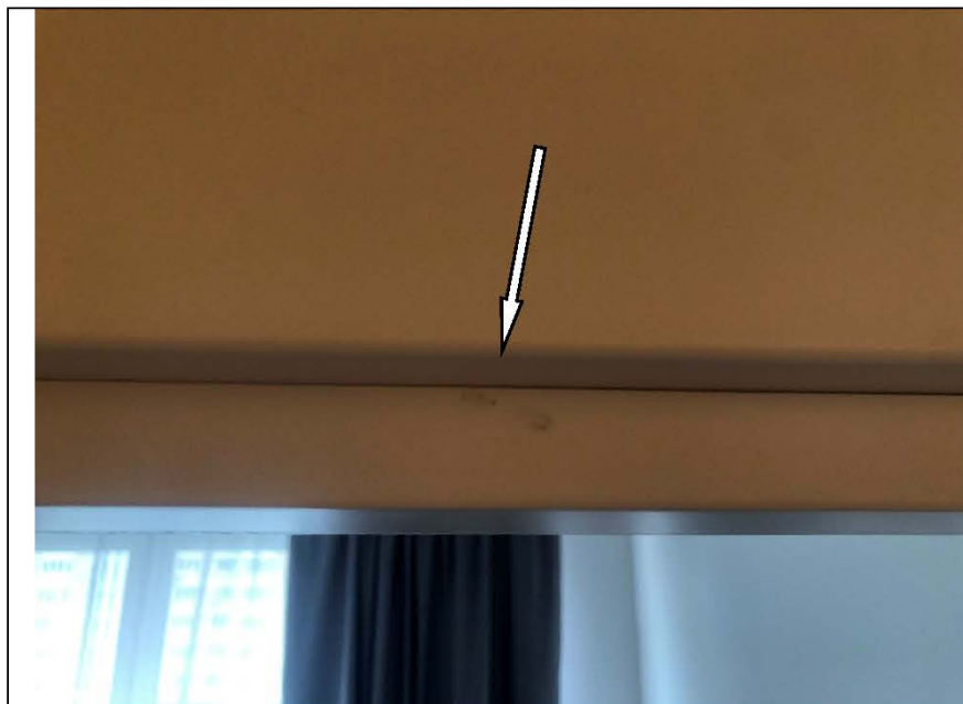
Фото №37. Загрязнение дверного блока в кухне.
