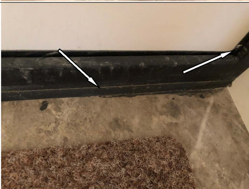
Фото №14. Загрязнение на блоке входной металлической двери и загрязнена напольная керамическая плитка.
