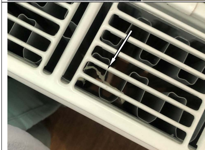
Фото №27. Загрязнение радиатора в детской в квартире.
