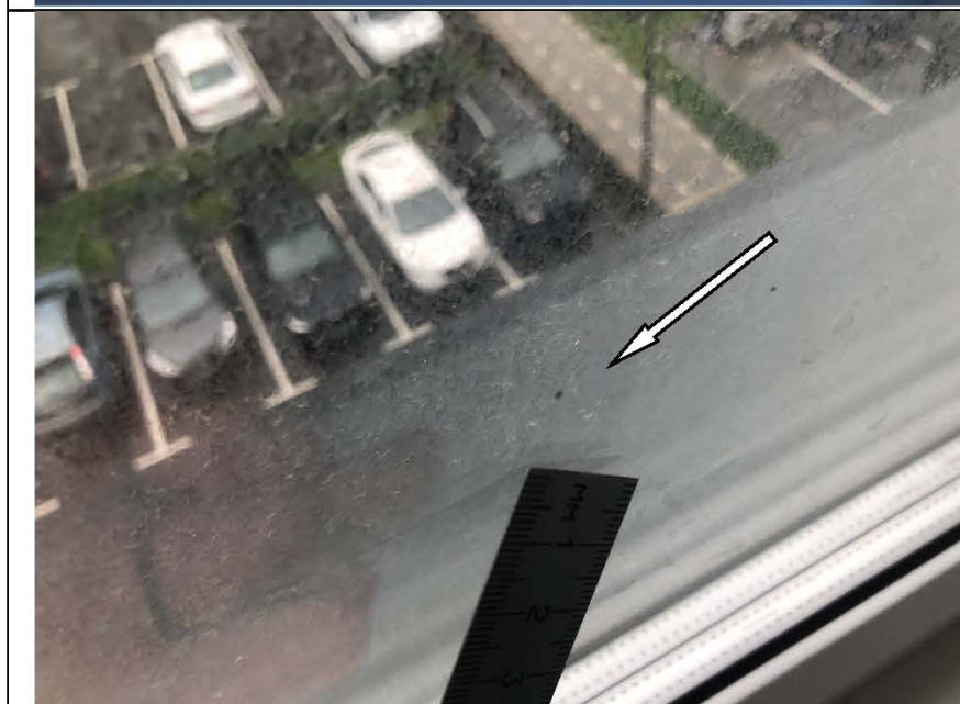
Фото №21. Окарины на стеклопакете оконного блока ПВХ в кухне.
