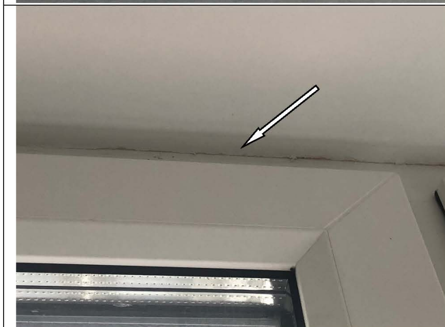
Фото №26. Щель между оконным блоком ПВХ и окрашенным откосом в кухне.
