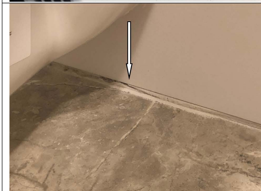
Фото №32. Загрязнение на напольной керамической плитке раствором в ванной комнате.
