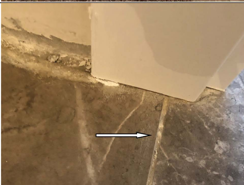
Фото №15. Неровный шов напольной керамической плитки в коридоре.
