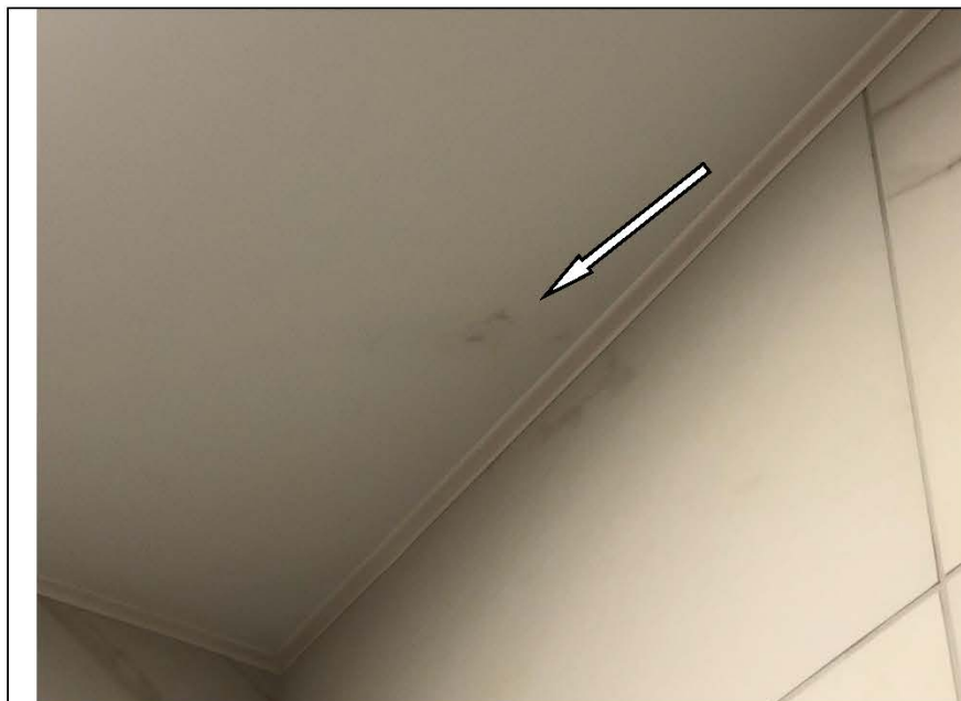
Фото №34. Загрязнение на натяжном полотне ванной комнате.
