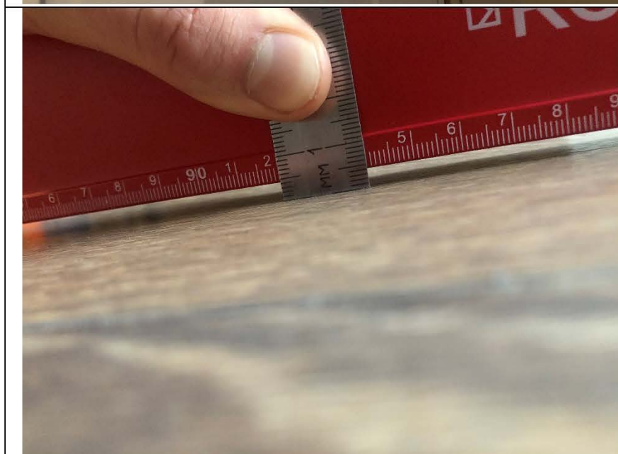
Фото №41. Измерение напольного покрытия в детской.
