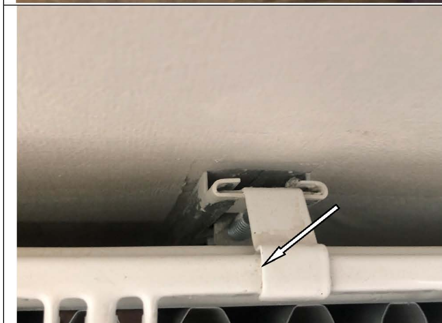
Фото №29. Загрязнения на кожухе отопительного прибора в детской.
