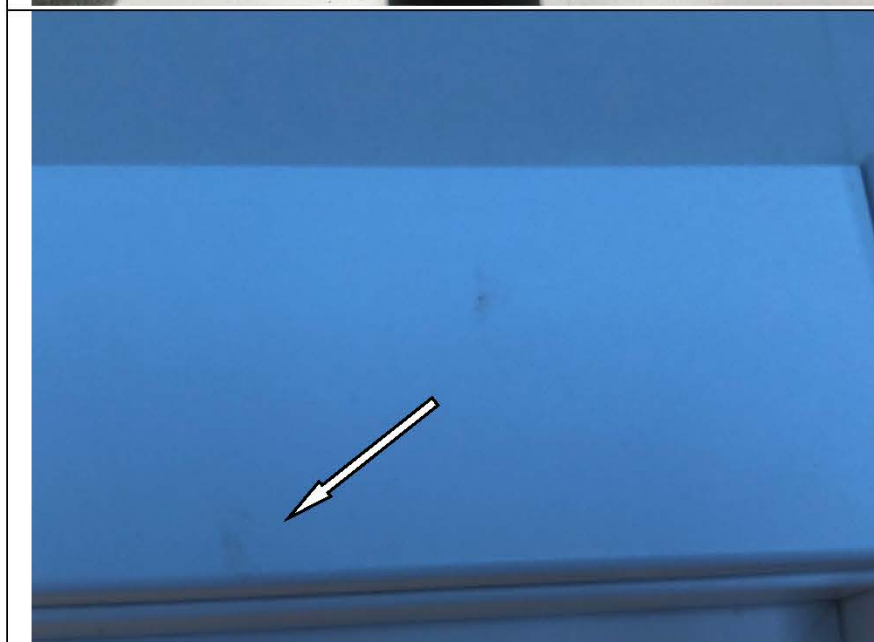
Фото №20. Загрязнение краской на стеклопакете оконного блока ПВХ в спальне.
