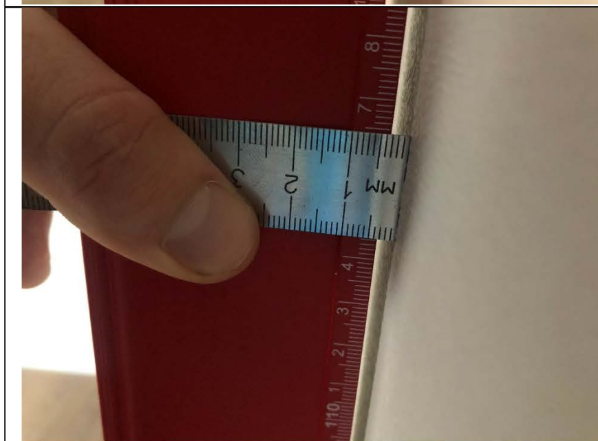
Фото №12. Измерение стен кладовки в квартире.
