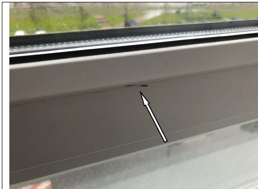
Фото №22. Загрязнение на профиле оконного блока ПВХ в кухне.
