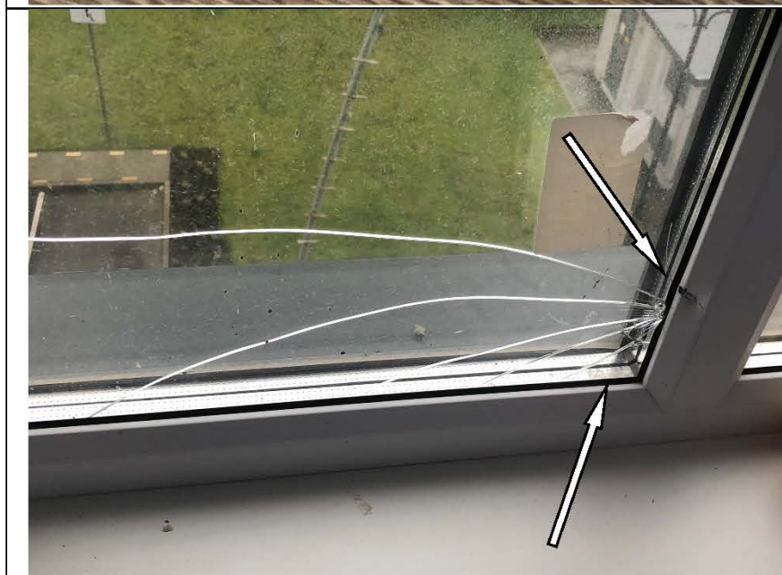
Фото №18. Трещина на стеклопакете оконного блока ПВХ и отбитости на профиле в детской.
